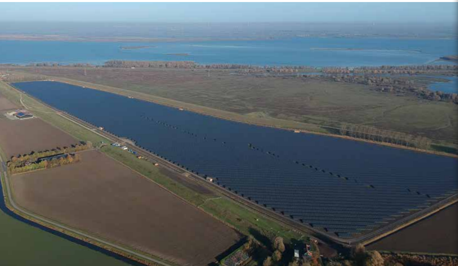
Ooltgensplaat, Goeree-Overflakkee, 32 Mw
